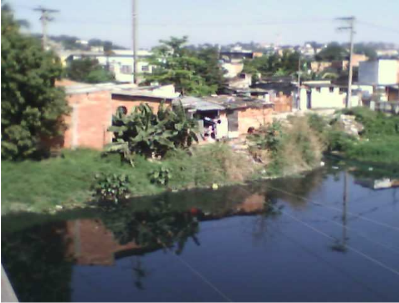
Foto 24– A ocupação desordenada do solo próximo às margens do rio que corta Campos Elíseos e tangencia a Reduc.
