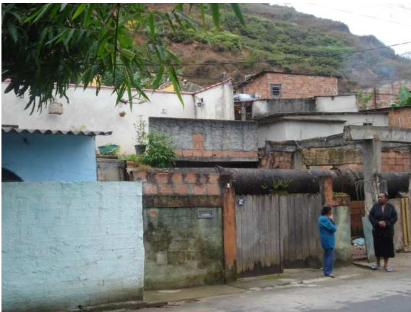
Foto 19 – As construções se deram sobre os dutos, mas também sob os dutos.
