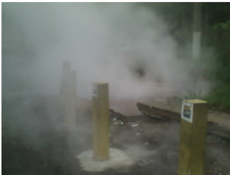
Foto 41 – Esse caldeirão a céu-aberto fica na Av. Fabor, na esquina da refinaria. Justamente onde começa a rota de fuga em caso de acidente.
